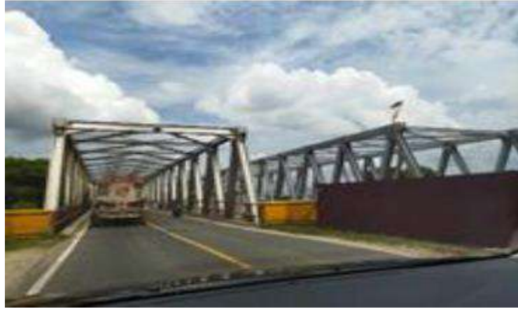
Gambar 2.68 Kondisi Jembatan Menuju Jambi
